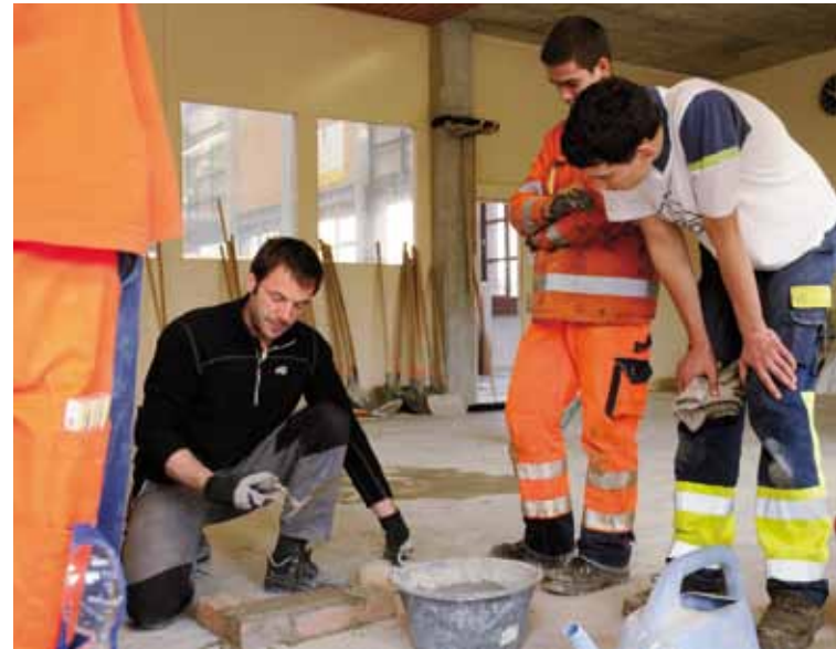
Kursleiter Michael Bandemehr führt die Lernenden Betriebsunterhalt im üK-Kurs in die Kunst der Mörtelherstellung ein.
